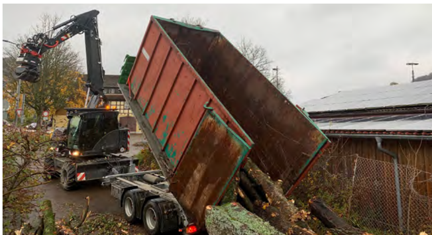
Es ist das Gesamtpaket, das zählt. Dank Zulassung als Zugmaschine dürfen mit dem Anhänger auch Schnitt - Material und Aushub transportiert werden.
