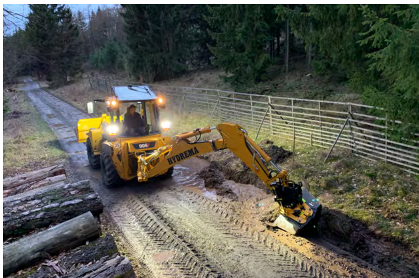
Das Ziehen von Entwässerungsgräben seitlich am Waldweg verläuft sehr einfach mit Blickrichtung auf den Arm
