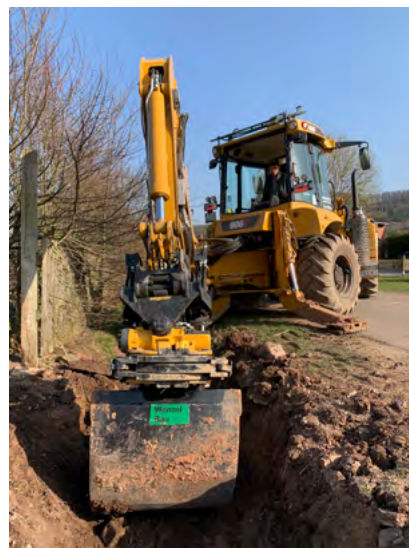
Der Mehrzwecklader von HYDREMA ersetzt auch einen 10 to. Mobilbagger beim Grabenziehen.
