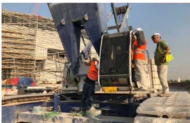
Ob es sich um einen Bagger, einen Kettendozer oder einen Raupenkran handelt, eine gründliche Inspektion ist immer notwendig Bildquelle: MEVAS
