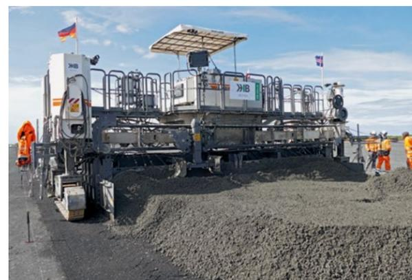
Auf dem Flughafen Keflavik baute der Wirtgen SP 62i den Beton einlagig auf 7,62 m Breite (25 ft) und in einer Stärke zwischen 41 cm (16 in) und 45 cm (18 in) präzise ein.
