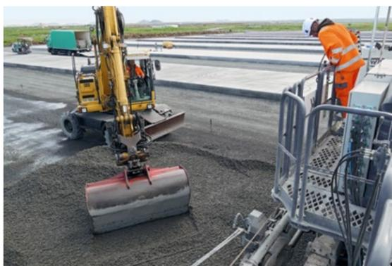
Der Beton wurde mit einem Bagger vor dem Gleitschalungsfertiger SP 62i abgelegt und anschließend mit dem Verteilerschwert der Maschine gleichmäßig verteilt.
