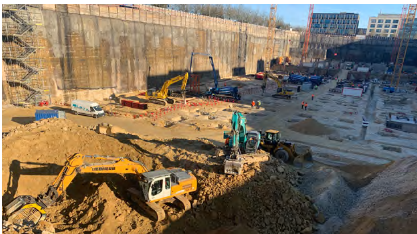
Kalksteinrecycling - BF120 Backenbrecherlöffel und MB-S18 Sieblöffel montiert auf Kobelco SK 350 und Liebherr 934
