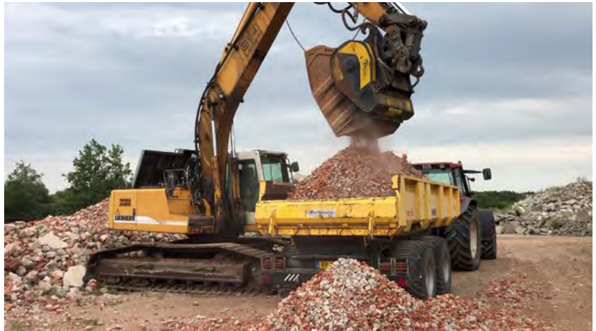
BF90.3 Backenbrecherlöffel mit Liebherr 914 Raupenbagger
